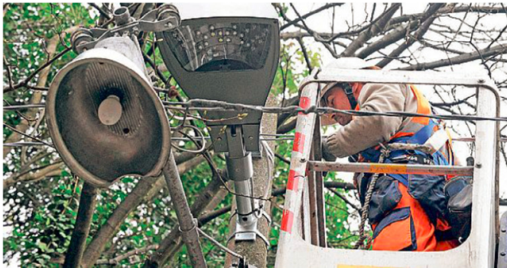
Un operaio Enel al lavoro. Il sindaco Giulia Mugnai più volte ha segnalato il problema di illuminazione
